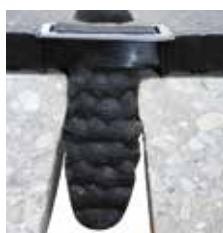
festelement: patentert gummiplugg mot sideveis glidning - i flukt med matten
