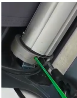
Bilde 1. Markisen er rullet helt ut slik at sylindren viser, da kan det bli svaiv i duken.
