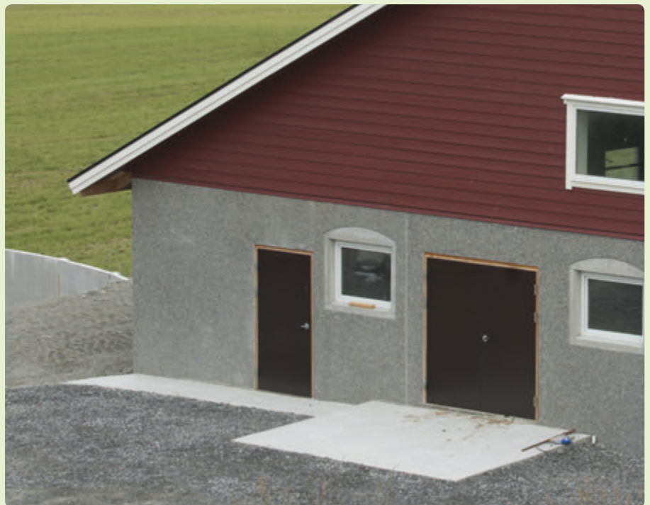
▲ Portane er så store at ein kan køyre med traktor gjennom dørøpingane.
