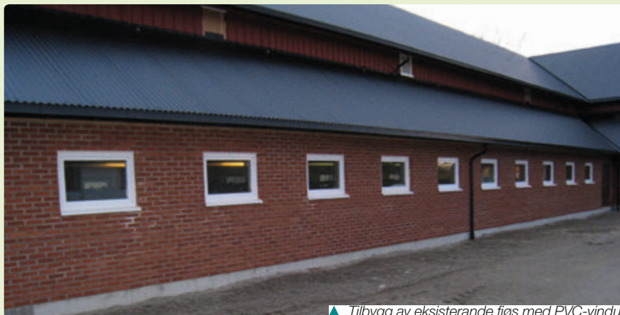
▲ Tilbygg av eksisterende fjøs med PVC-vindu.
